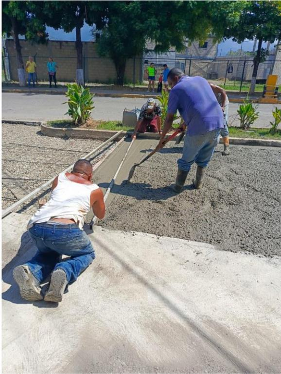
Miércoles 11 de octubre de 2023, se recibe 1 camión premezclado premex para el vaciado de las 3 restantes losas de concreto.
