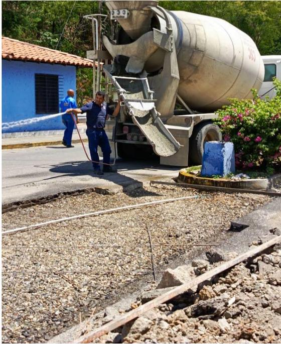
Viernes 29 de septiembre de 2023, se recibe 2 camiones premezclados premex para el vaciado de los 4 restantes losas de concreto, igual manera se fija los anclajes para la colocación de las barandas del paso peatonal, para la culminación del tramo vehicular del lado de propietarios.
