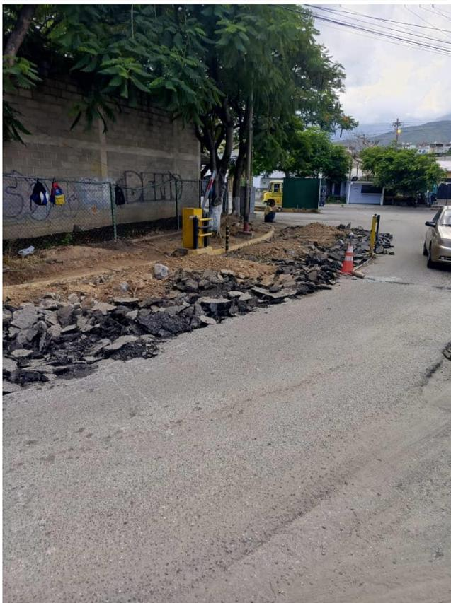
Miércoles 27 de septiembre de 2023, se procede de forma manual y con martillo hidráulico la demolición del paso peatonal. Recolección de escombros, mediante maquinaria tipo retroexcavadora y camión de volteo IVECO de 18 toneladas.
